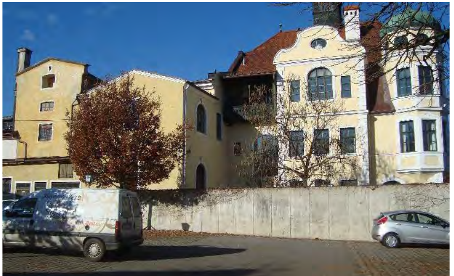
Fotostandort 14 – Blick auf Wiener Villa Marktstraße 1
