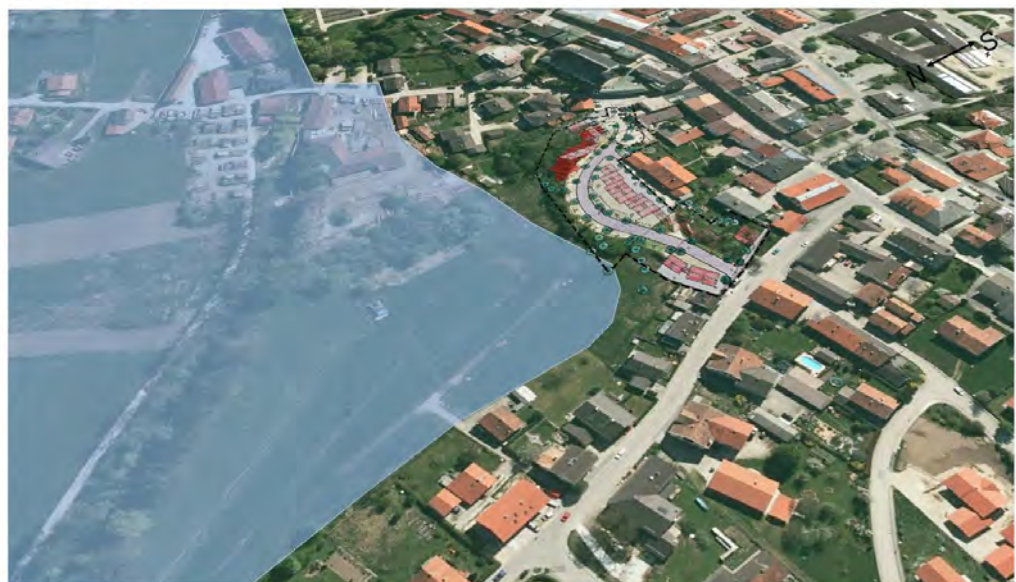
Luftbild Brunnpunt mit Überschwemmungsgebiet
