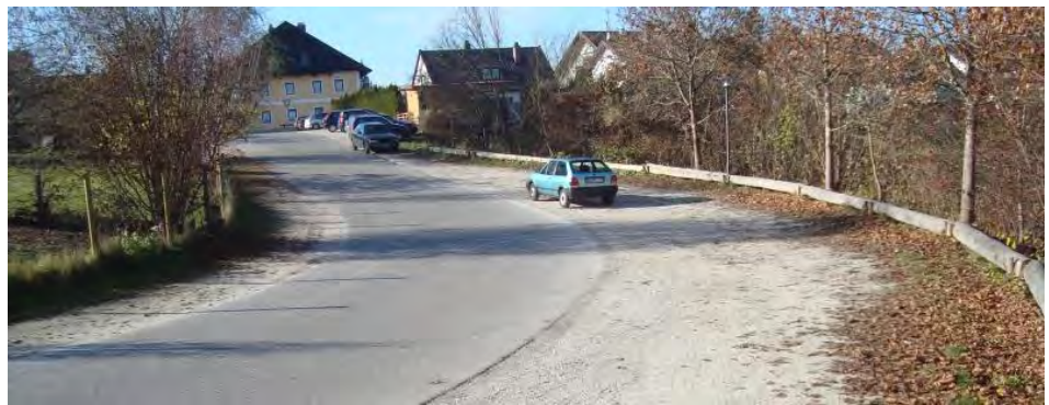
Fotostandort 7 Erschließungsstraße Brunnpoint auf Holzhauser Straße 7
