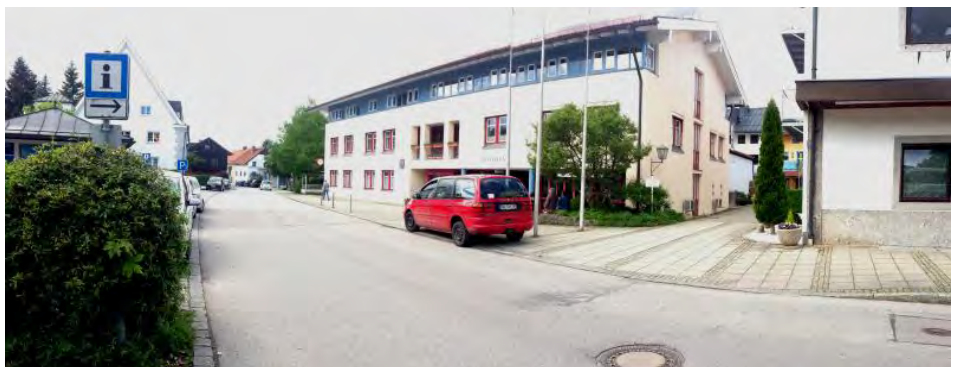
Fotostandort 12 – Blick auf Rathaus Markt Teisendorf- Poststraße 14
