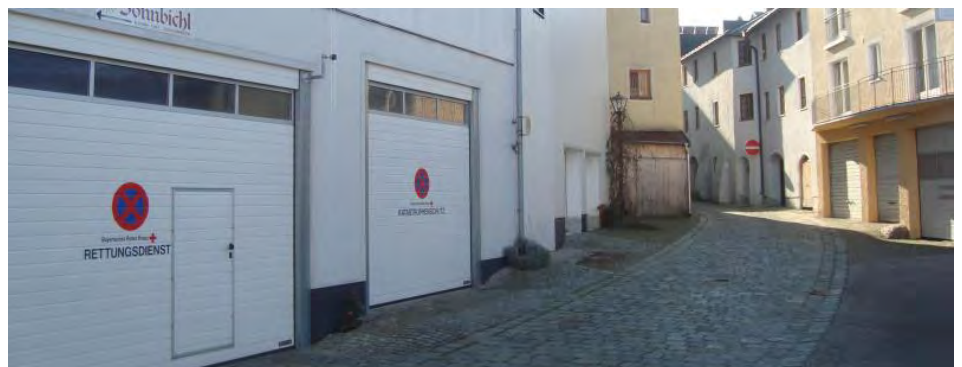
Fotostandort 11 Einmündung Brunnpunkt, Wimmererstraße in Richtung Süden Marktstraße
