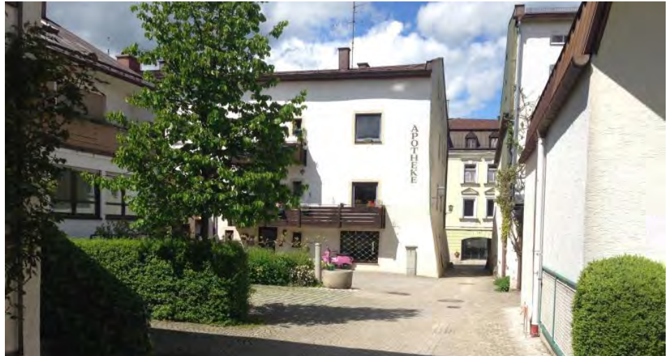
Fotostandort 38 – Blick auf Hauptmannsgasse
