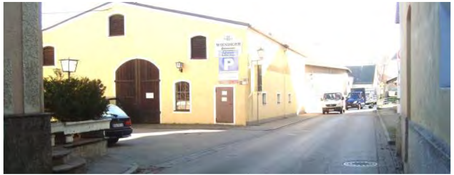
Fotostandort 9 – Blick auf Alte Reichenhallerstraße 1
