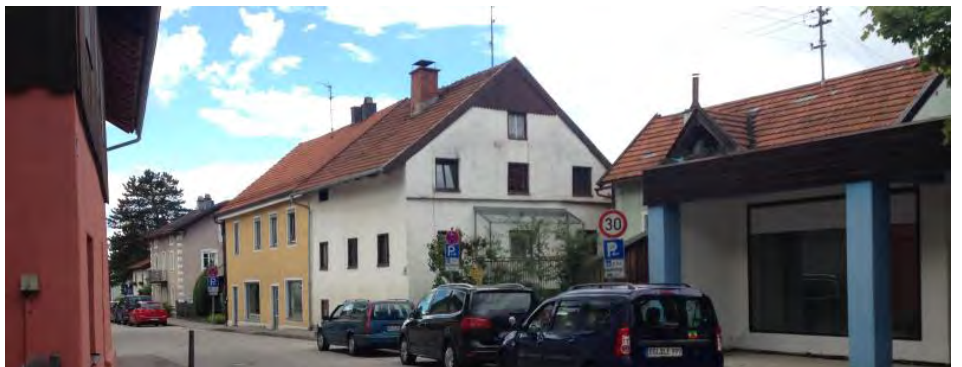
Fotostandort 15 – Blick auf Poststraße 18-22-24-28
